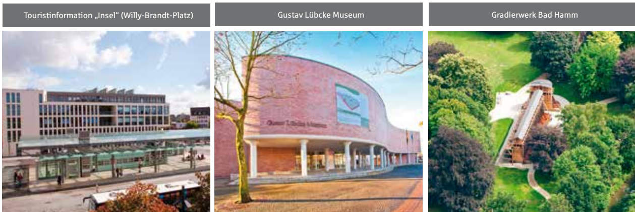
Abb. 47: Hamm – Ansichten ausgewählter Infrastrukturmaßnahmen
